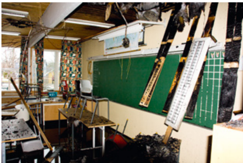
Store skader også på Åsgården skole.
