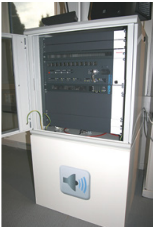
Slik ser et talevarslingsrack ut.
